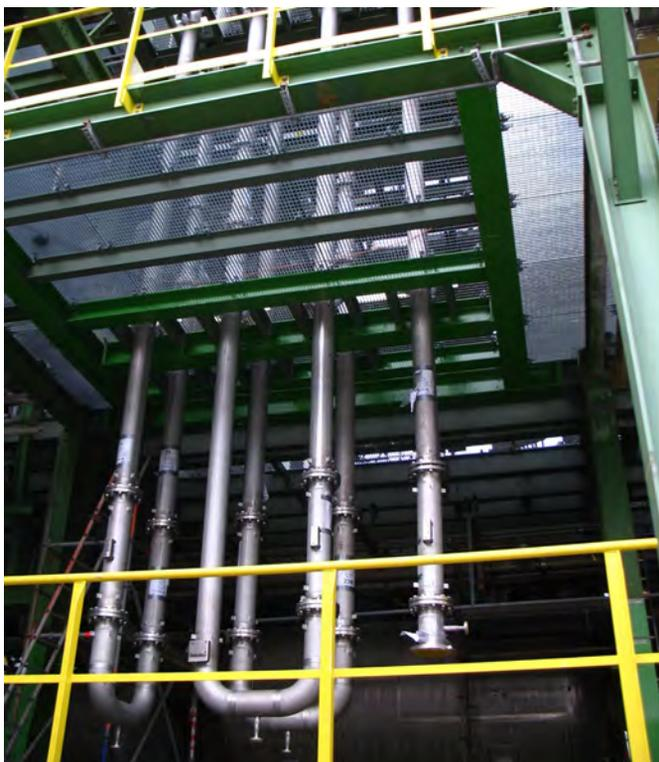
Die AGENS AMV Geometrie kann in den unterschiedlichsten Reaktortypen realisiert werden. Das Spektrum reicht von kleinen Statikmischern 1" bis zu großen Rohrreaktoren.
